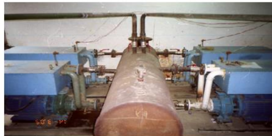
Рис. 8 Четыре вихревых теплогенератора, отапливающие фабрику (ООО «Градиент»).
